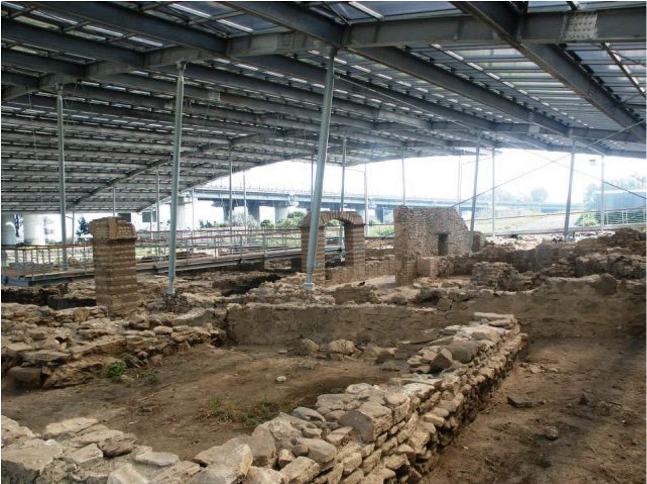
Fig.1. Copertura a struttura metallica sui resti della villa romana di Patti Marina. Foto dell'autore
