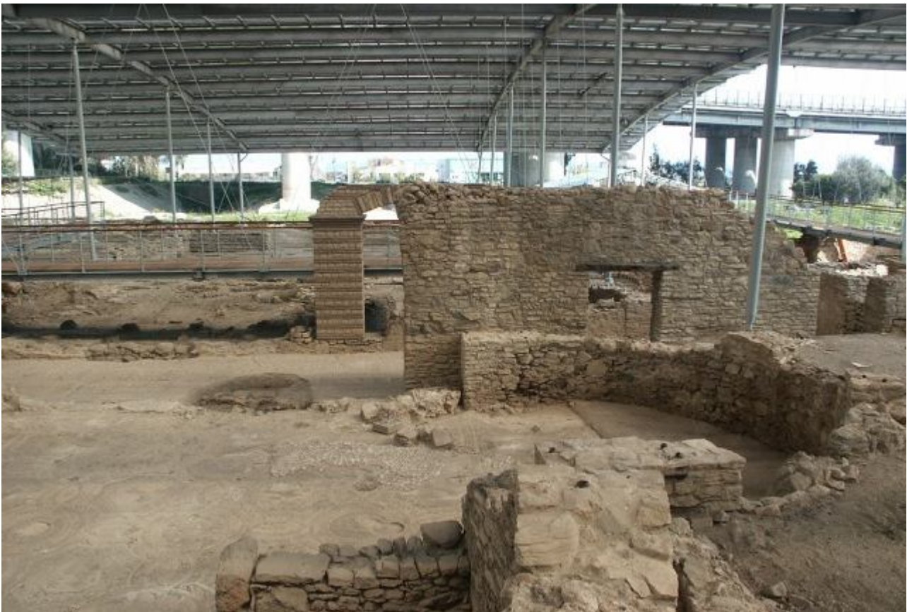
Fig.2. Copertura a struttura metallica sui resti della villa romana di Patti Marina. Foto dell’autore
